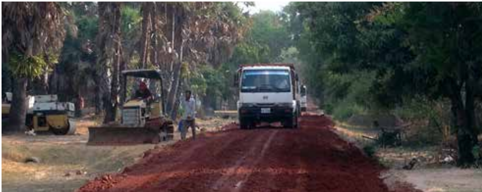
Landsbyvejen repareres af kommunen efter anmodning fra landsbysammenslutningerne. Ampil kommune. Feb. 2016.
